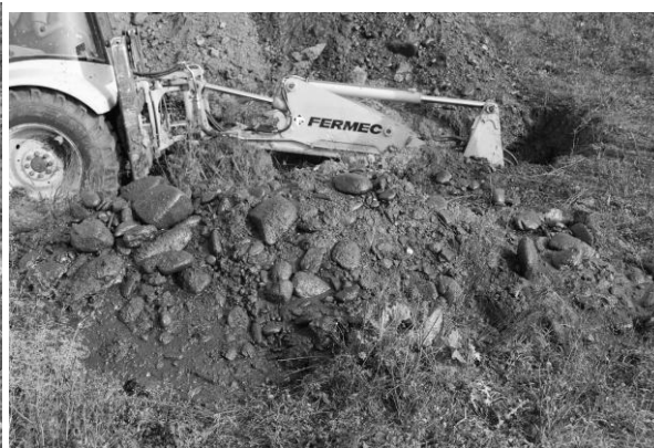
Fig. 3 Execuție șanț de investigare
